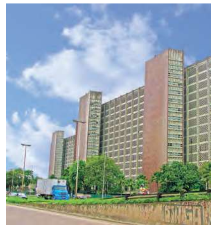
Em 2017, o antigo prédio que sediava a Sudene passou a ser administrado pela Universidade Federal de Pernambuco (UFPE). Novos projetos voltados à universidade estão sendo elaborados para aproveitamento de sua estrutura e localização. Na foto, registro atual da antiga sede.
